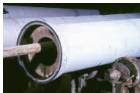
Rivestimento interno in cemento
