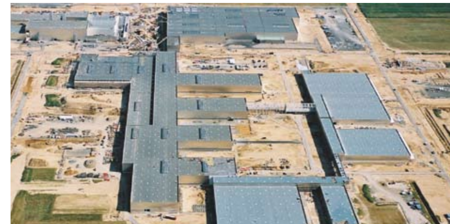
Il tetto di 85.000 m 2 viene scaricato con efficacia con la tubazione in acciaio GM-X e con i captatori JET®.
